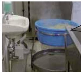
手洗い設備と食品の取扱い場所が近すぎて、手洗いの洗浄水が食品に飛散する恐れがある。
